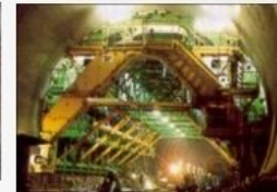
Construccion de Restauracion
